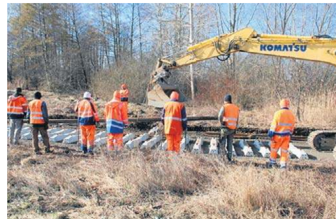
Prace w terenie już się rozpoczęły, mają się zakończyć jeszcze przed wakacjami tego roku
