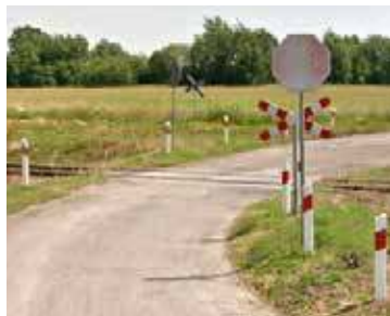
Na wniosek PKP przejazdy kolejowe położone na drodze nie mającej statusu publicznego powoli są zamykane, jeśli nikt nie wnosi sprzeciwu
