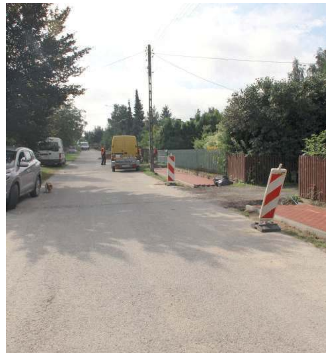
Ekipa brukarska kończy układanie chodnika w Rudach
