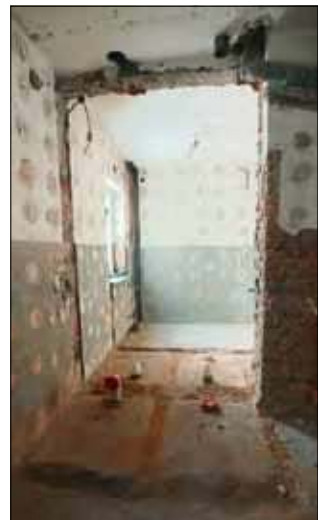
Prace w budynku ośrodka kultury rozpoczęły się w styczniu.
