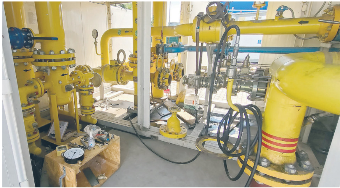
Modernizowana stacja redukcyjna gazu
