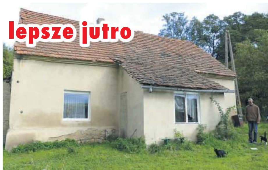
Dom wynajmowany przez pana Arka wymaga gruntownego remontu
