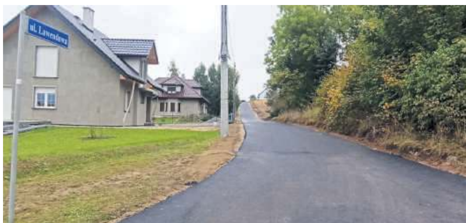
Po zakończeniu prac na ul. Lawendowej w Gęsińcu, mieszkańcy mają normalny dojazd do swoich posesji
