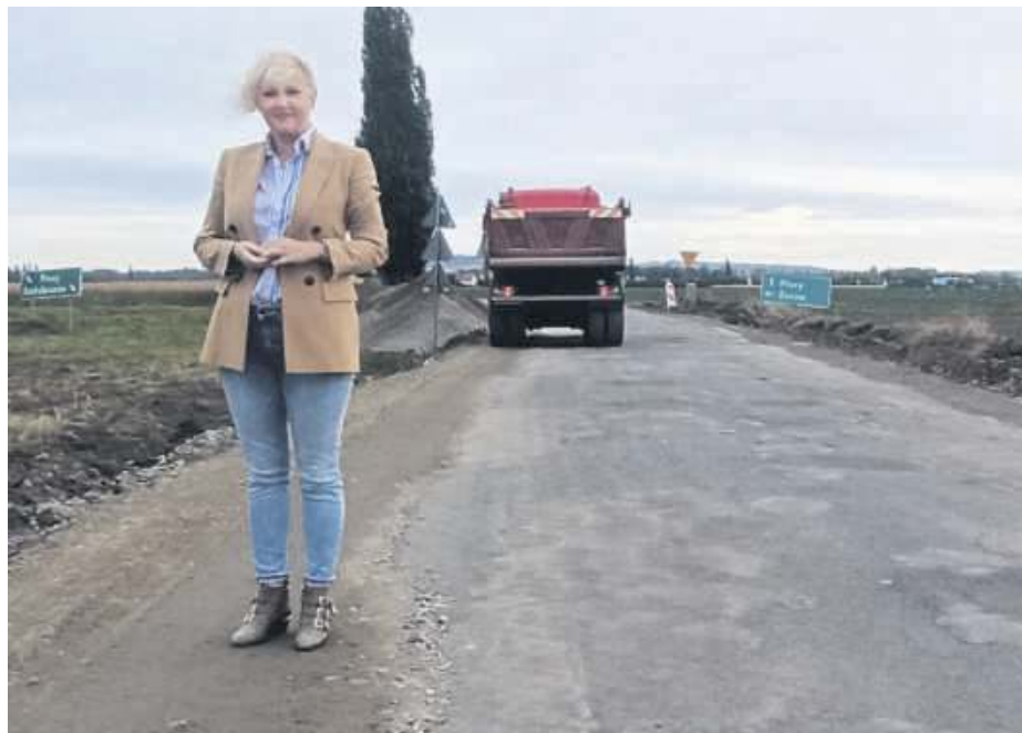
Jedną z ważniejszych inwestycji powiatowych na terenie gminy Kondratowice jest remont drogi Kondratowice-Białobrzegie. Na zdjęciu radna powiatowa Ewelina Andrzejewska-Bochnak na placu budowy
