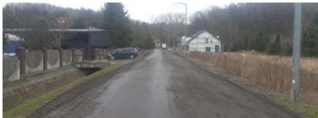
Ulica Sybiraków znajduje się na wyjeździe z Puław w stronę Kazimierza Dolnego. Podczas prac modernizacyjnych planuje się m.in. wylanie asfaltu
