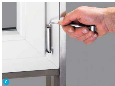
Regulacja: docisku rygla (a), rozwórki (b), zawiasów (c). Smarowanie okuć (d). MS WIĘCEJ NIŻ OKNA
