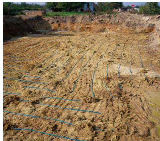
📍 Wykop pod poziomy kolektor gruntowy. CLIMA KOMFORT
