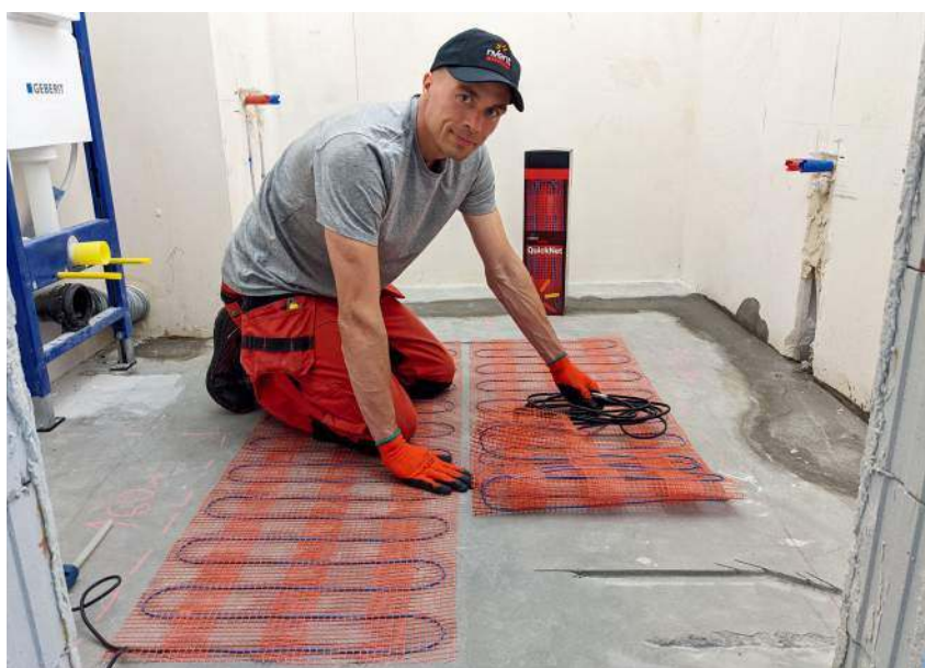
❶ Układanie maty grzewczej. NVENT RAYCHEM
