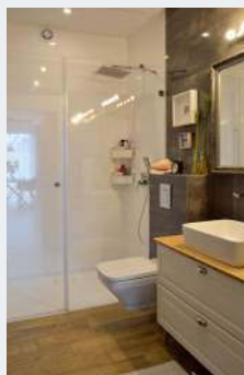
● Zamontowano wysokie (220 cm) przeszklenie z drzwiami.
