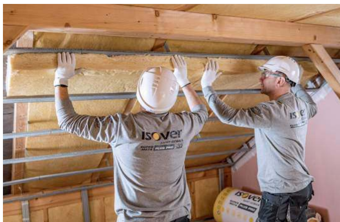
🔦 Wełna mineralna to najpopularniejszy materiał do ocieplania dachów skośnych. ISOVER
