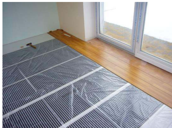
❶ Folia grzewcza o grubości 0,4 mm układana bezpośrednio pod panelami. FENIX POLSKA
