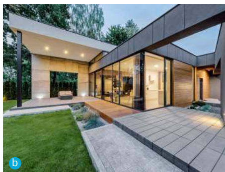
❶ Szklane fasady, ogrody zimowe (a VEKA) oraz przeszklania kątowe obejmujące narożniki bez pionowego słupka (b G-U POLSKA/BECZAK & BECZAK) wykonuje się z profili aluminiowych.
