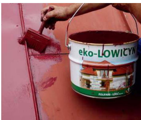
Dach pokryty blachą co kilkanaście lat można odnowić, malując farbą. POLIFARB ŁÓDŹ
