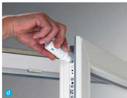
Regulacja: docisku rygla (a), rozwórki (b), zawiasów (c). Smarowanie okuć (d). MS WIĘCEJ NIŻ OKNA
