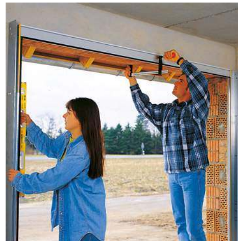
❸ Aby brama działała prawidłowo, trzeba dokładnie wypoziomować ościeżnicę i prowadnice. HÖRMANN
