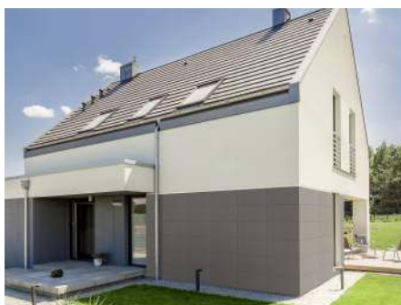
📍 Elewacja wykończona tynkiem w najmodniejszych kolorach bieli i szarości. LAKMA
