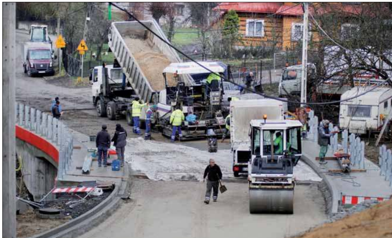
W sobotę wykonawca kładł asfalt na nowym moście.
