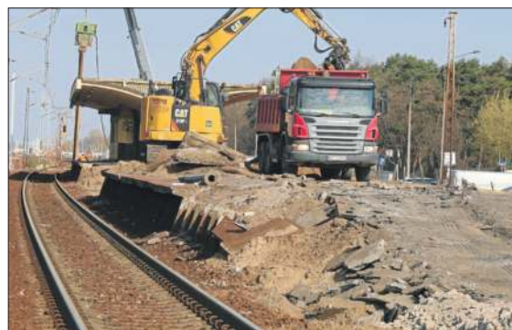
Modernizacja linii kolejowej w Otwocku
