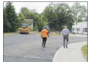
Dzięki przeprowadzonym pracom droga dojazdowa m.in. do nowego komisariatu policji jest zmodernizowana
