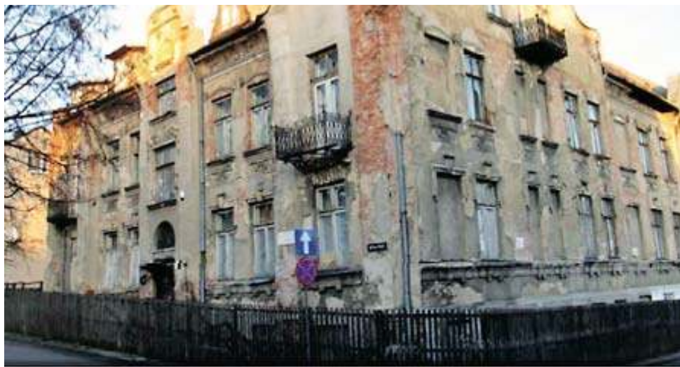
Stara secesyjna kamienica przy Zielonym Rynku. Budynek do rozbiórki
