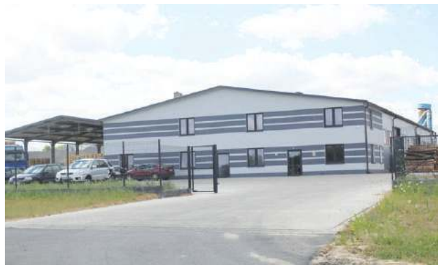
W podstrefie swój zakład wybudował biznesmen zajmujący się przemysłem drzewnym
