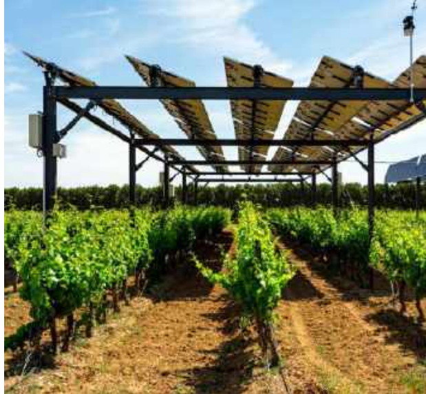
1. Jedna z instalacji agrofotowoltaicznych we Francji
