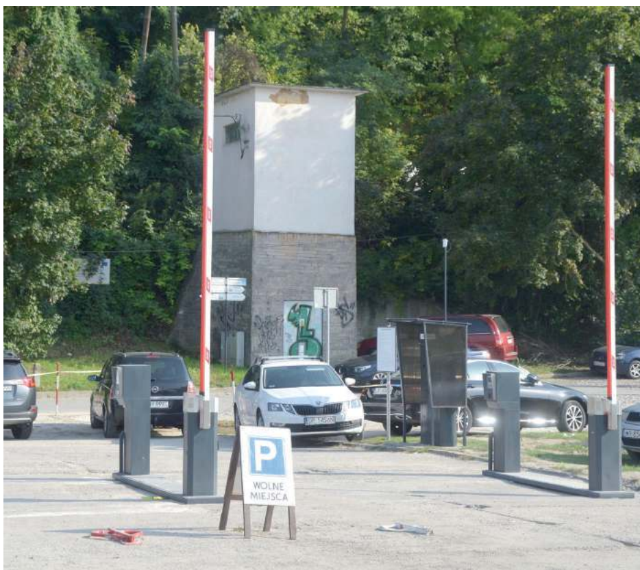
Szlabany umożliwiające wjazd na teren parkingu zostały już zamontowane
