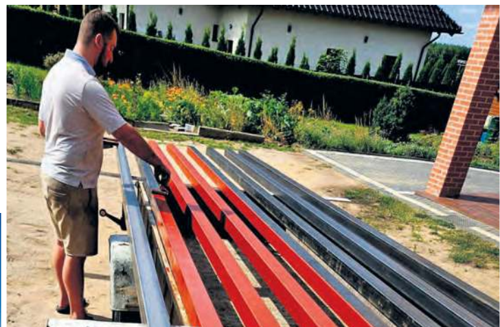
Prace związane z odświeżeniem słupów oraz przygotowaniem lamp solarnych do montażu radny Karol Sikorski wykonał samodzielnie.
