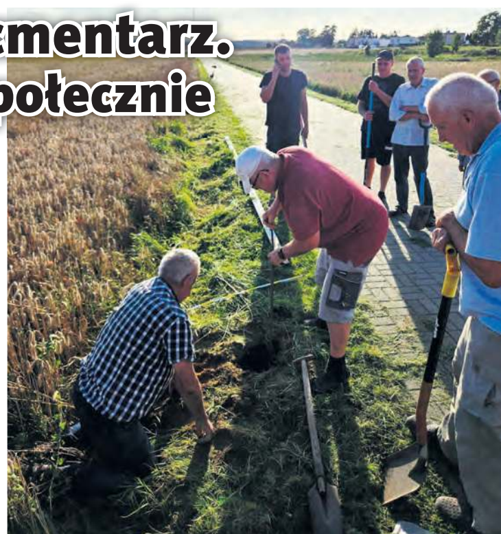
Mieszkańcy Żalna chętnie włączyli się w prace montażowe.
