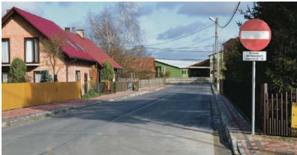
W ostatnim czasie w Rudniku nad Sanem wyremontowano m.in. ulicę Harcerską
