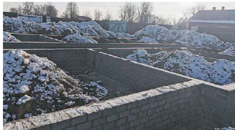
Proces budowy Hospicyjnego Domu Aniołków można śledzić na FB Fundacji Z Serca Dla Serca
