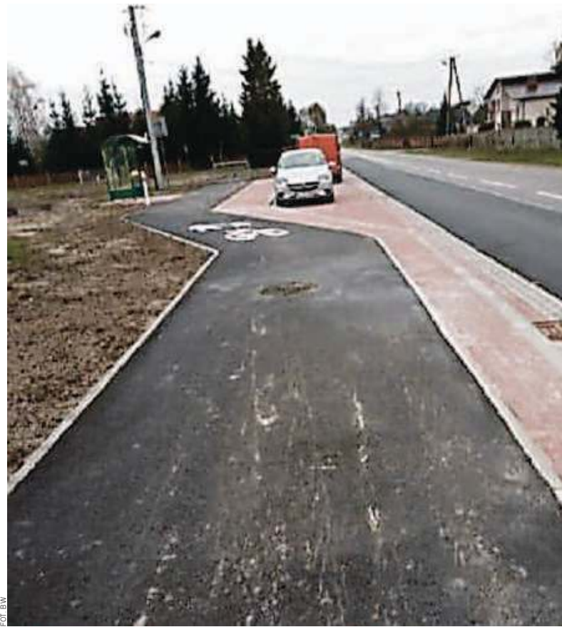
Mieszkańcy Jaty, Zalesia i Sójkowej w gm. Jeżowe od blisko 20 lat zabiegali o budowę ścieżki pieszo–rowerowej wzdłuż drogi wojewódzkiej. Teraz gdy powstał blisko 420-metrowy jej odcinek, chcą by dobudowano jeszcze brakujące 300 metrów ścieżki
