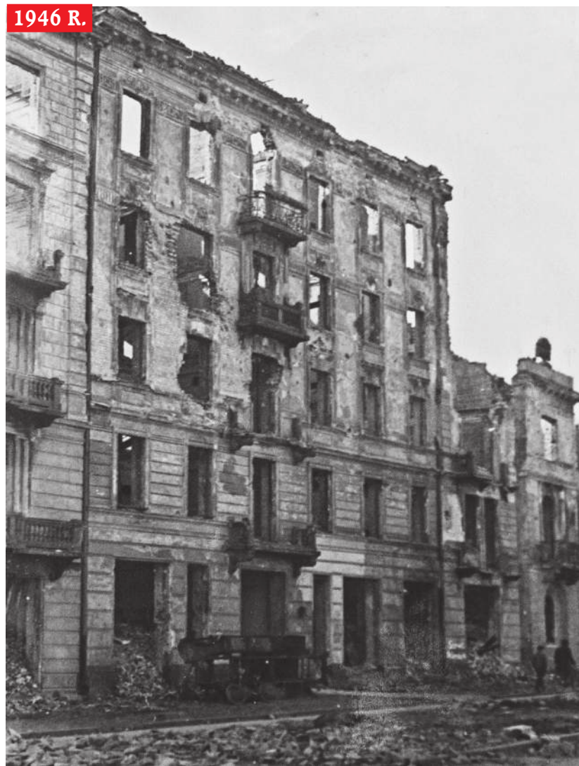
Kamienica przy ul. Długiej 11, zburzona w 1946 r. na zlecenie BOS. Akta BOS. Zbiory Archiwum Państwowego w Warszawie | fot. Tomasz Hamrat/Gazeta Polska
