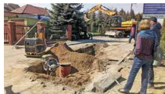
Budowa sieci kanalizacyjnej ul. Wiśniowa i Winogronowa
