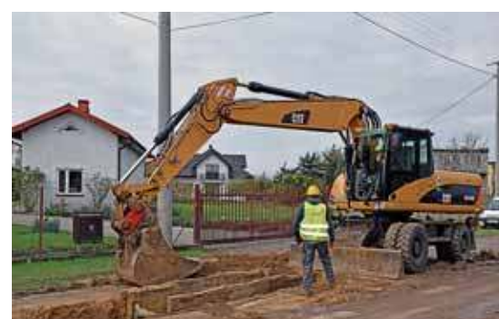
Budowa sieci kanalizacyjnej ul. Białowiejska
