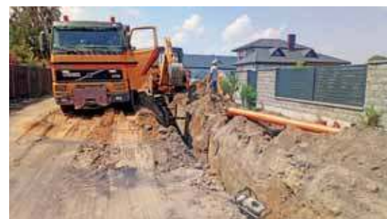
Budowa sieci kana- lizacyjnej Osiedle Śniegockiego
