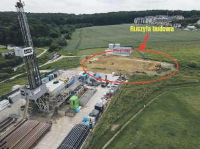
Zdjęcia z dnia 10.06.2025. Widać nowe prace ziemne
