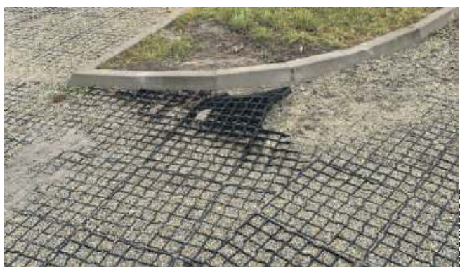
Uszkodzona nawierzchnia parkingu
