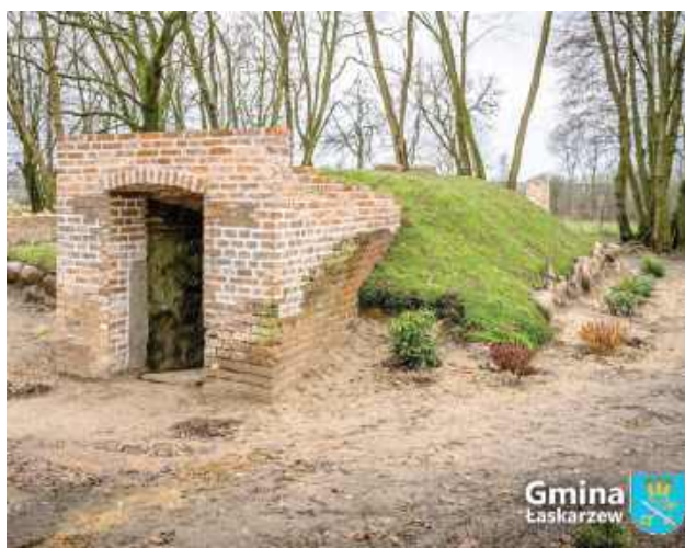
Przeprowadzono remont starej ziemianki
