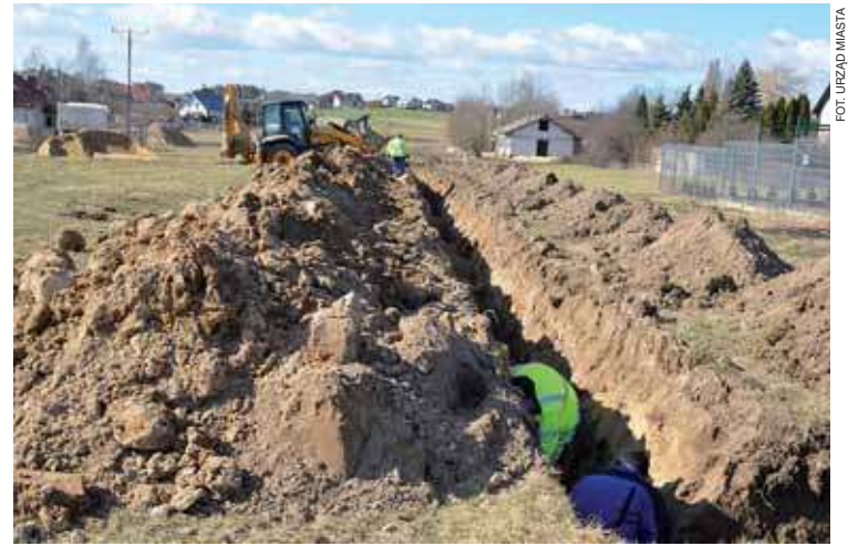
Prace przy ul. Husarskiej
