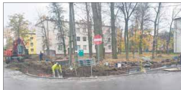
Nowy chodnik już powstaje
