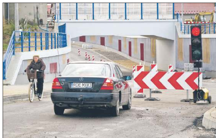
Pod przejazdem trzeba zachować ostrożność, bo prace jeszcze trwają.
