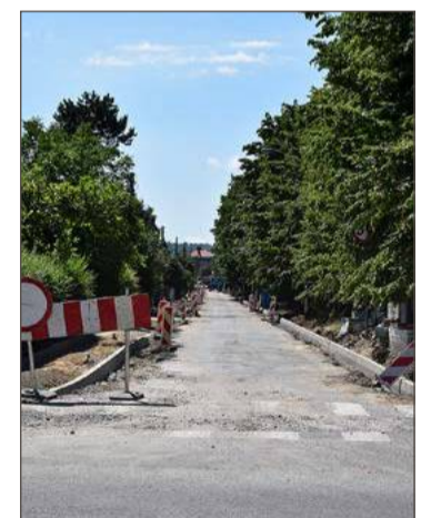
Przy ul. Grunwaldzkiej prace już trwają.
