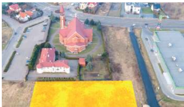
Nowy miejski żłobek miałby powstać za kościołem pw. Brata Alberta (fot. UM Łuków)
