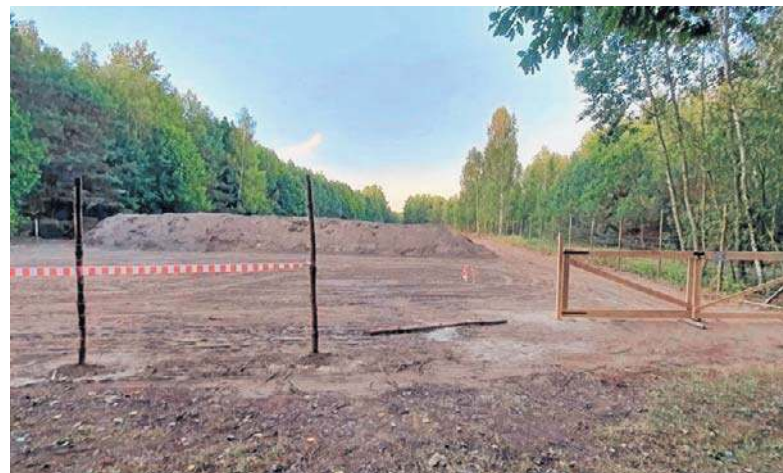
Od kilku dni w Drożankach w gminie Gózd trwają prace związane z przygotowaniem terenu pod strzelnicę na świeżym powietrzu.
