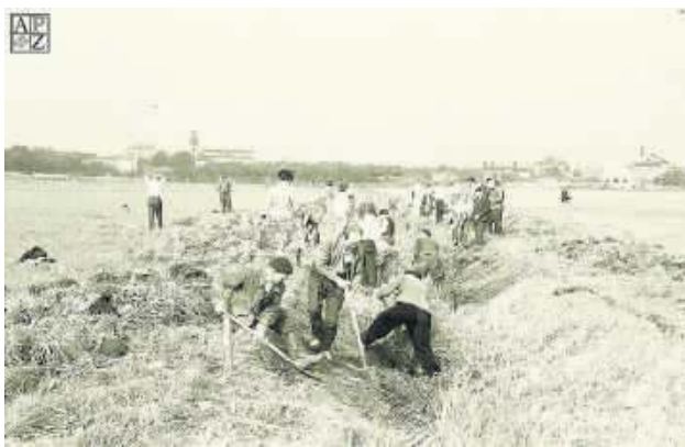
1961 rok. Budowa zamojskiego zalewu. Ze zbiorów APZ.
