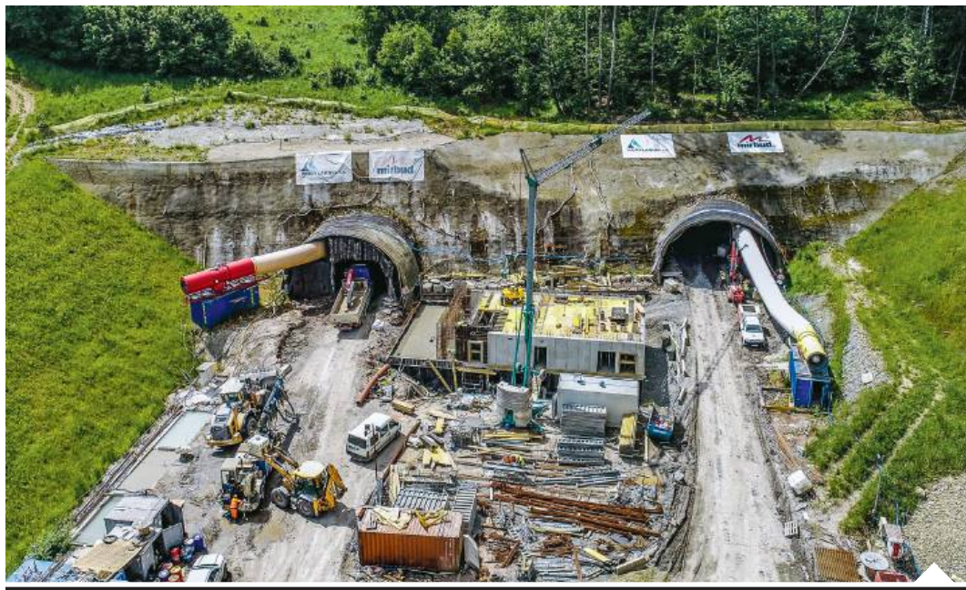
Budowa dwóch tuneli w ciągu budowanej drogi ekspresowej S1 na odcinku Przybędza – Miłówka w woj. śląskim | fot. GDDKiA/d
