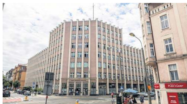
Z dachu ZUS, protestujący zrzucali urządzenia zagłuszające zachodnie radiostacje
