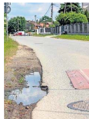
Przebudowa ulicy Rybitwy ruszy w październiku
