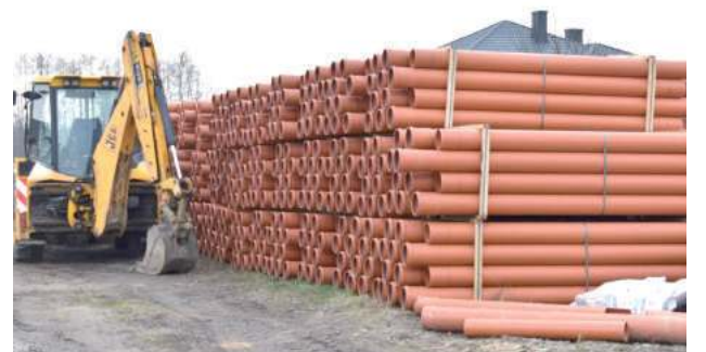
W Majdanie Nowym i Majdanie Starym trwa budowa kanalizacji sanitarnej
