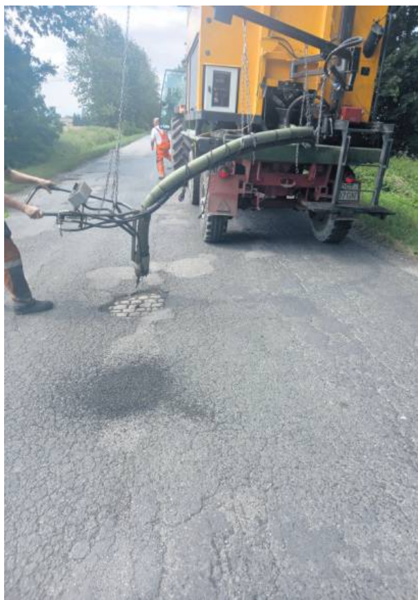
Od kilku tygodni niektóre prace remontowe na drogach powiatowych prowadzone są z wykorzystaniem widocznego na zdjęciu remontera.
