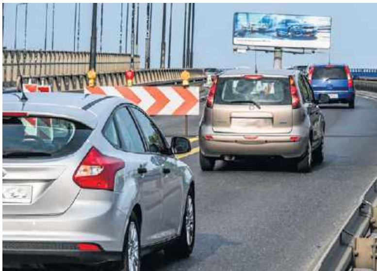
Pod koniec 2020 r. ZDMiKP informował o złym stanie Wiaduktów Warszawskich. Prace pod wiaduktem zakończono w 2022 roku
