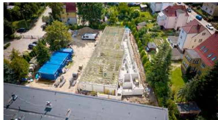
Budowa żłobka miejskiego na os. Zachód. Fot. UM
