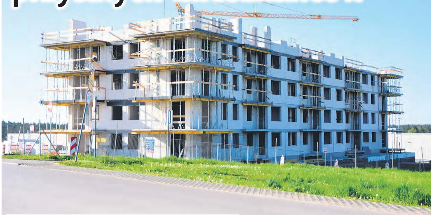
Prace postępują. W ostatnim kwartale tego roku ma nastąpić pierwszy etap zasiedlenia.
