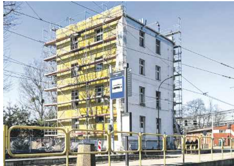
Po kapitalnym remoncie budynek znowu będzie przydatny
