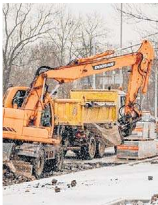
Trwa remont na drugim odcinku ul. Pabianickiej
