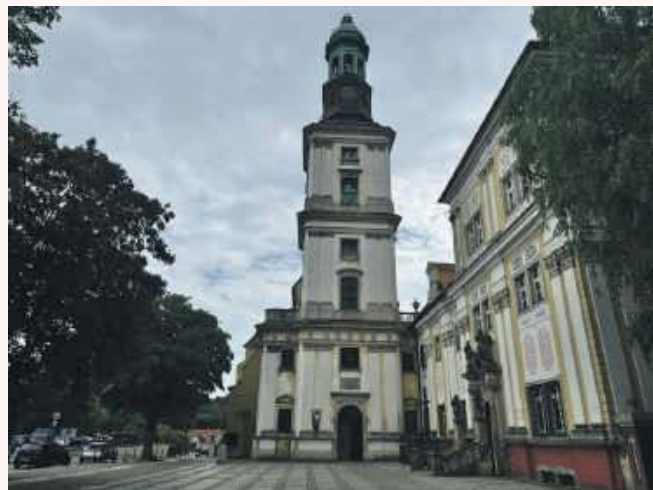
Prace konserwatorskie w Bazylice
