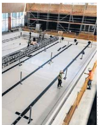
Trwa montaż niecek basenowych z ruchomym dnem
