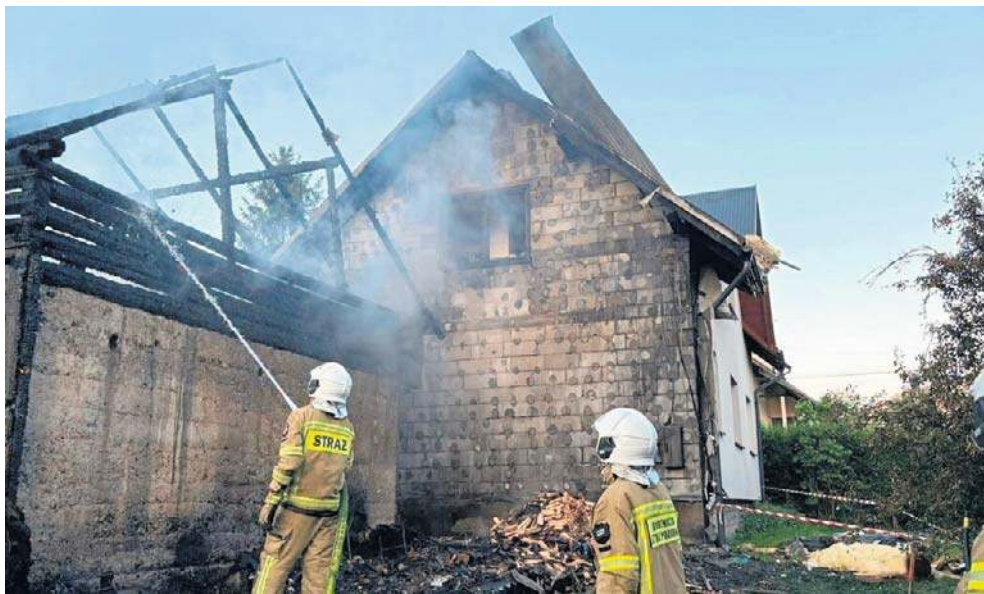
Z pożarem stodoły i domu walczyło aż 85 strażaków oraz 19 samochodów pożarniczych
