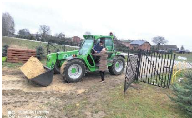
Wykonawca informuje, że świetlica wiejska w Olszance może być gotowa już w tym roku
