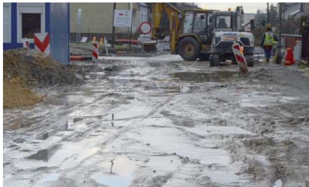
Remont ulicy Piłsudskiego w Biłgoraju potrwa do listopada 2023 roku
