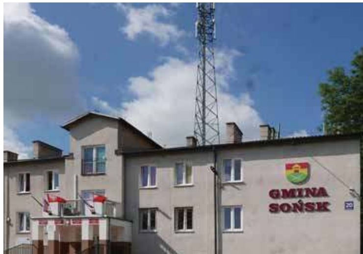
Do sieci gazowniczej zostanie przyłączony m.in. Urząd Gminy w Sońsku
