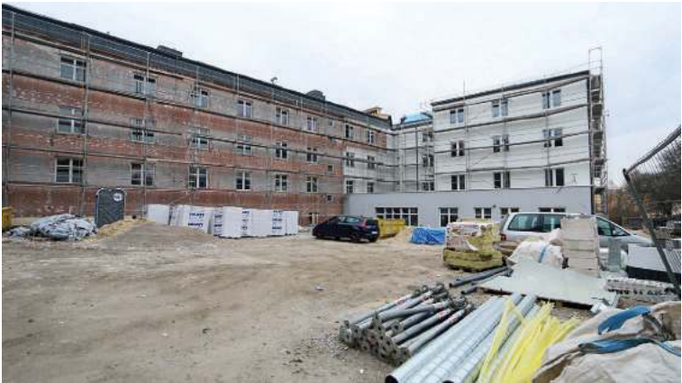
Odbudowa DPS-u po pożarze już kosztowała ponad 2,2 mln złotych
