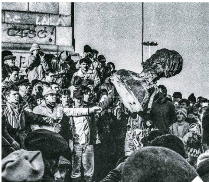
Gdy w Warszawie demontowano pomnik „żelaznego Feliksa”, opasująca go stalowa lina spowodowała, że nagle rozpadł się na kilka kawałków! Rzekomo spiżowy pomnik był wypełniony pod cienką warstwą metalu marnym cementem! To znakomity symbol komunizmu – pozory potęgi, a pod spodem nędza | fot. Włodzimierz Wasyluk/Gazeta Polska
