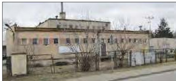
Widok nieruchomości budynkowej od strony ul. Grunwaldzkiej
