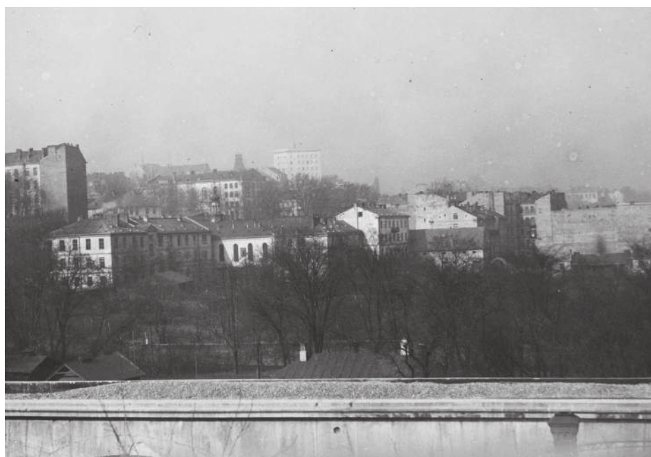
Widok na Powiśle z wiaduktu mostu Poniatowskiego. Na pierwszym planie budowany wiadukt linii średnicowej, 1928–1931, źródło: NAC
