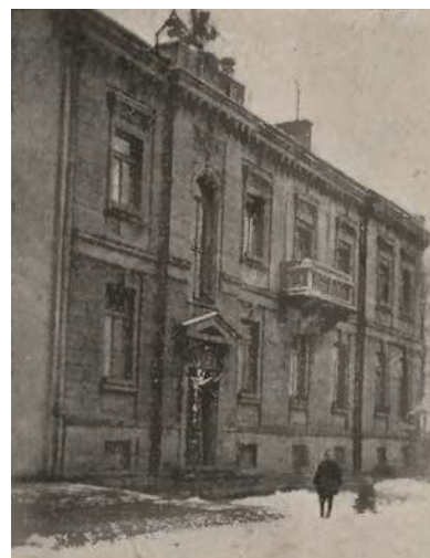
Gmach Inspekcji Sieci Wodociągowej i Kanalizacyjnej przy ulicy Lipowej 2, źródło: „Wodociągi i kanalizacja m. st. Warszawy 1886–1936”
