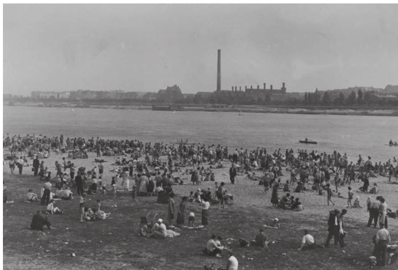
Tłum osób na plaży po praskiej stronie Wisły. W tle elektrownia na Powiślu, 1931, źródło: NAC
