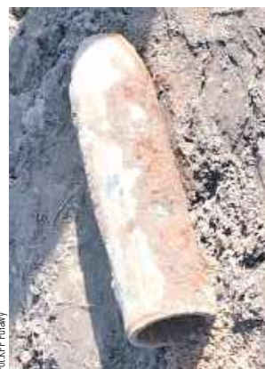
Mundurowi wstrzymali budowę drogi do momentu, gdy saperzy zabezpieczyli niewybuch i wywieźli go w bezpieczne miejsce, by następnie zneutralizować
