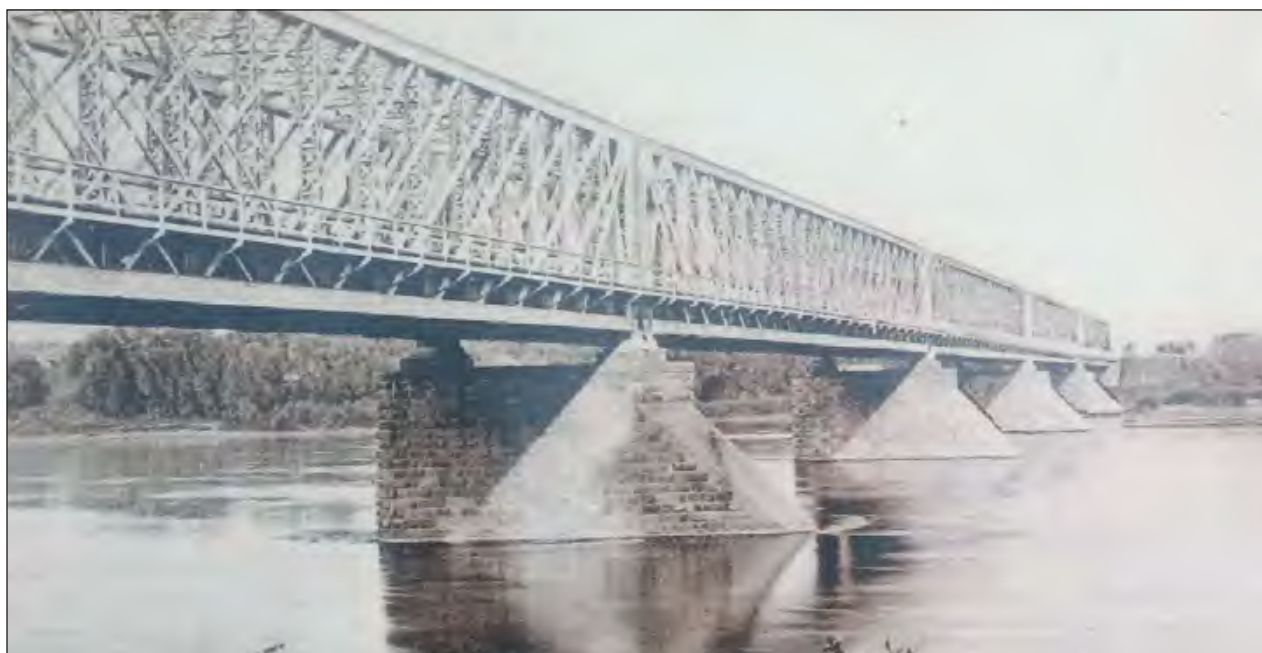
■ Największym mostem na trasie Drogi Żelaznej Nadwiślańskiej był ten pod dęblińską twierdzą. Zdjęcie pochodzi z pocztówki z kolekcji Marcina Medyńskiego
