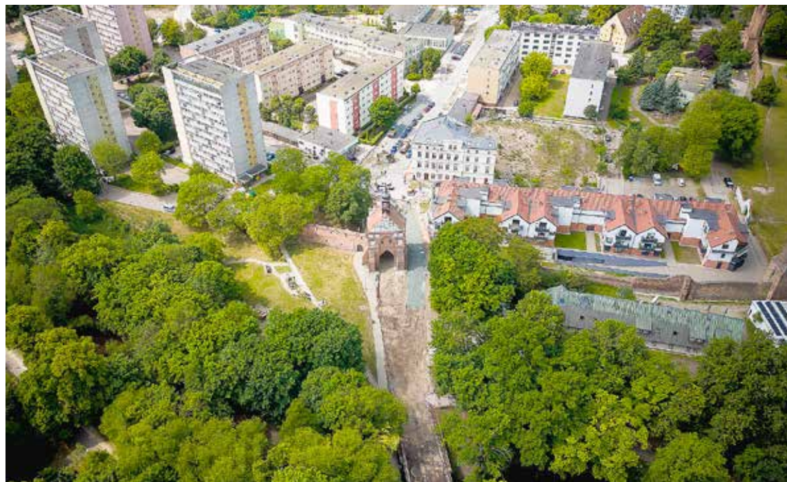
Tak z lotu ptaka wygląda przebudowa ulicy Chrobrego. Fot. Sebastian Ler
